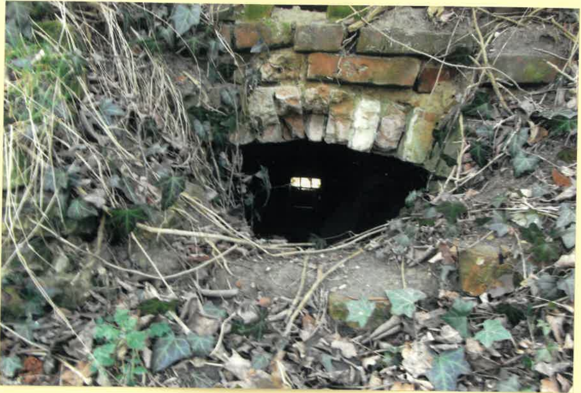
Fot.6. Otwór w ścianie północnej krypty rodziny Adamy z widocznym naprzeciwko otworem wentylacyjnym w ścianie południowej pomnika.
