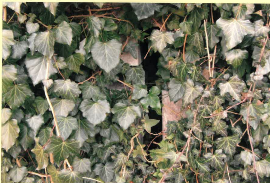
Fot.9. Przykład rozwiązania otworu wentylacyjnego na północnej ścianie jednej z krypt na cmentarzu, mogący posłużyć za wzór przy rekonstrukcji ściany północnej krypty rodziny Adamy.
