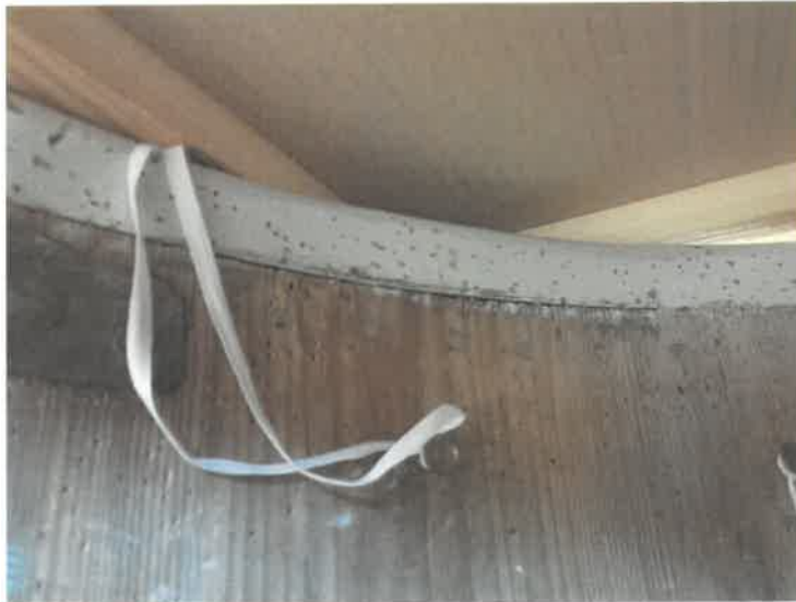
Fot. 1: Uszkodzenia mechaniczne warstwy malarskiej oraz drewna. Fot. Aleksandra Krajewska-Łapiak.
