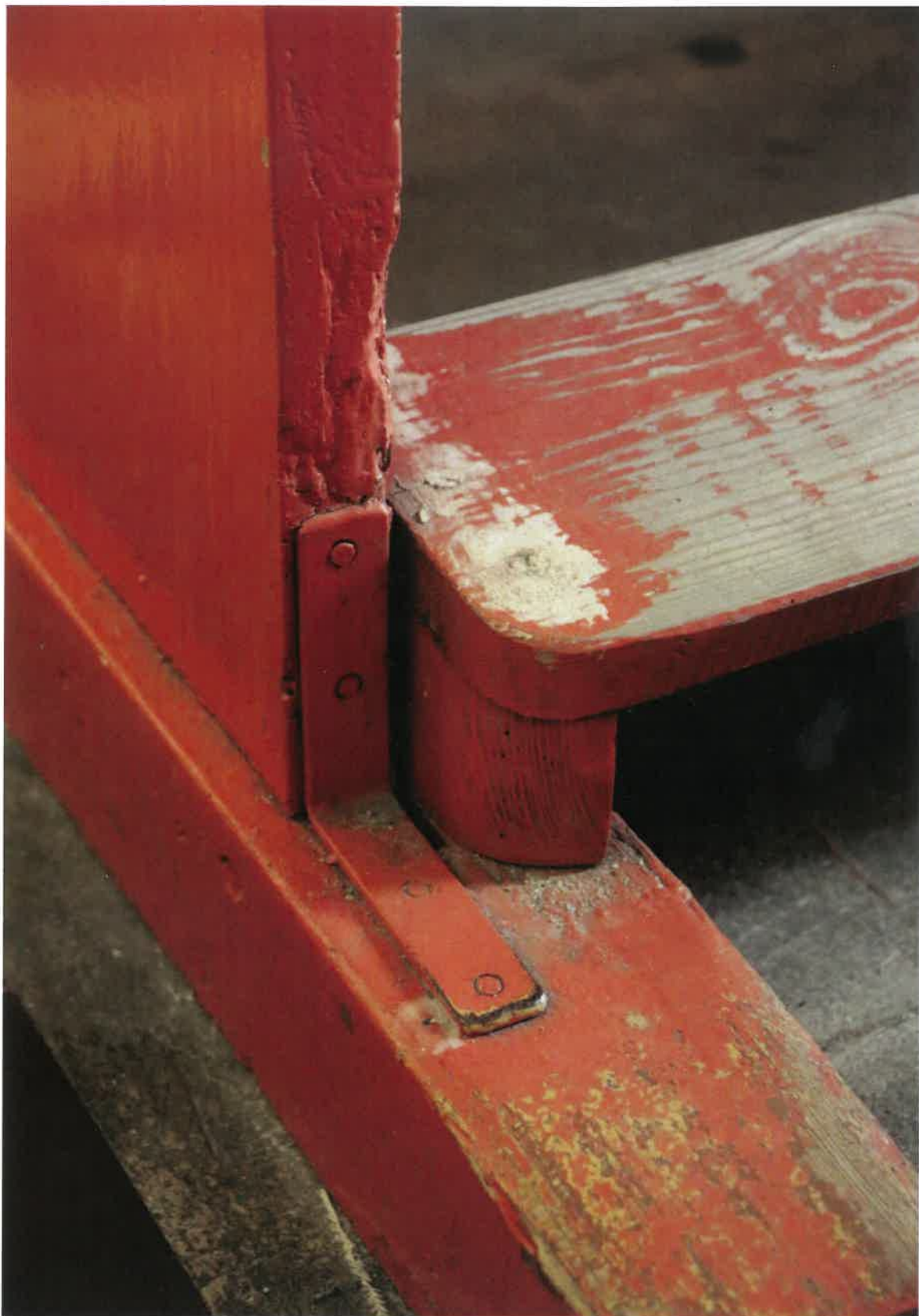
Fot. 7. Fragment deski klęcznikowej. Sposób jej montażu, pozbawiony integracji z policzkami, może świadczyć o wtórności tego elementu. Widoczny metalowy kątownik, stabilizujący konstrukcję. Pod nim, w płozie widoczny fragment gniazda, po brakującej części boku ławki.
