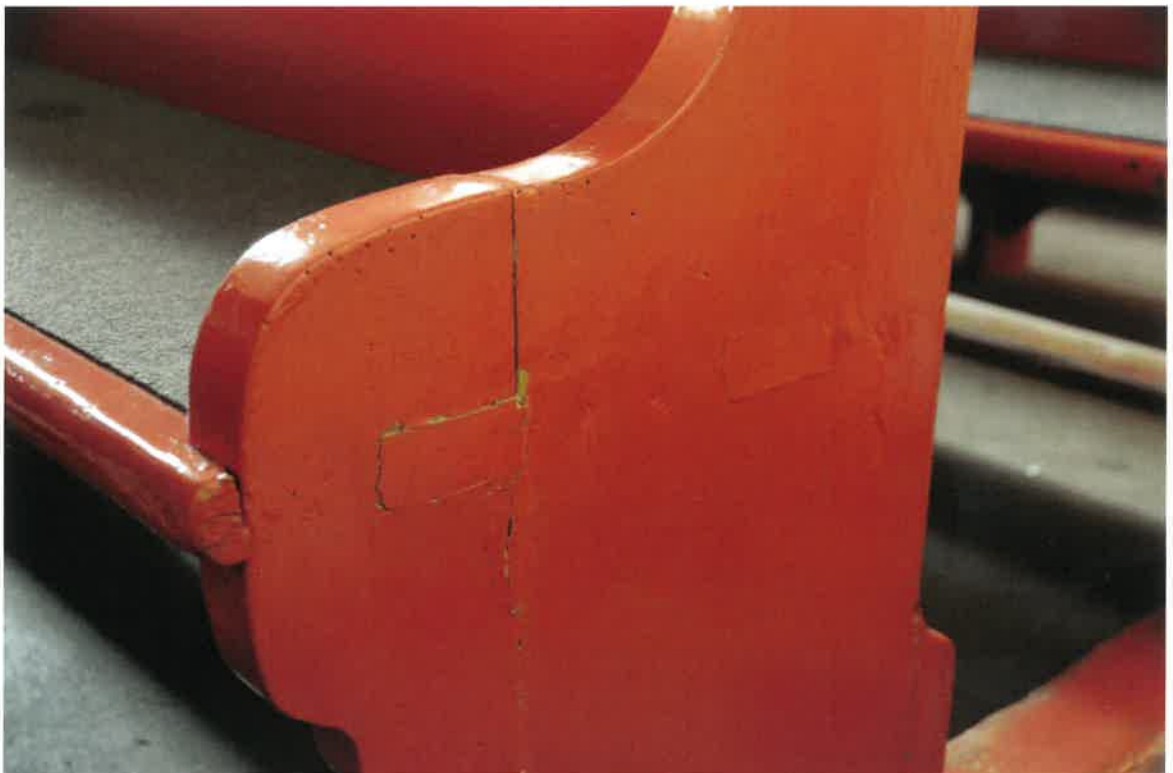
Fot. 10. Fragment policzka ławki. Dostrzegalne czopy siedziska osadzone w boku, rozpojenie drewna w miejscu klejenia oraz otwory wlotowo-wylotowe owadów.
