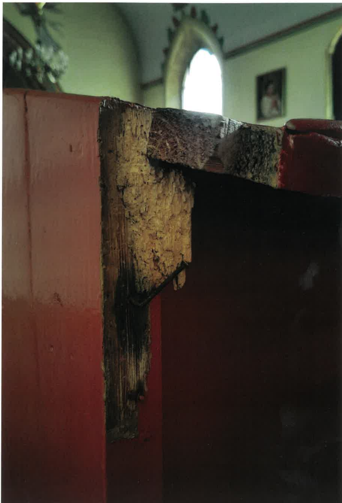
Fot. 13. Drewno całkowicie zniszczone przez ksylofagi. W wyniku żerowania owadów tkanka drzewna utraciła swoje właściwości fizyczne i się rozsypała.
